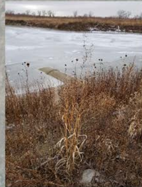
Site 1: Levee embankment
